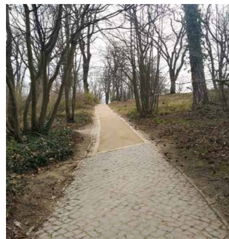
Abbildung 1: Partielle Pflasterung von besonders erosionsgefährdeten Wegeabschnitten im Park Babelsberg © SPSG, Katharina Matheja
