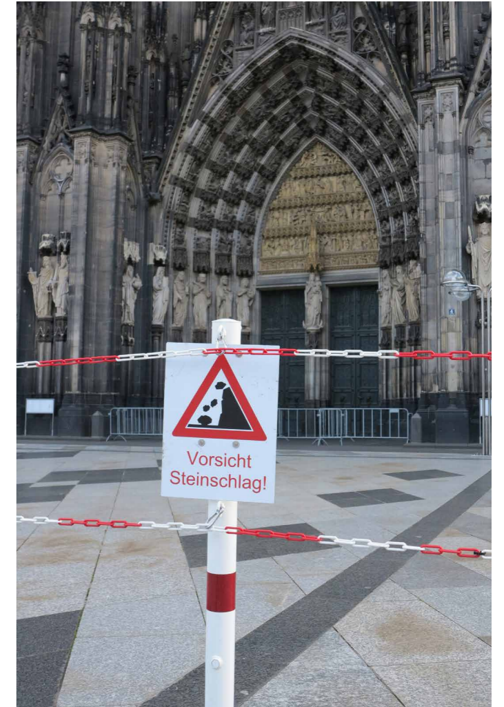
Abbildung 8: Gewährung der Sicherheit von Passanten durch großräumige Absperrung um den Dom © Hohe Domkirche Köln, Dombauhütte
