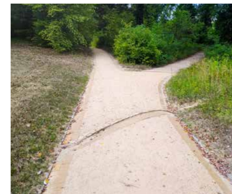
Abbildung 4: Verdoppelte Klinkerrinne zur Wegeentwässerung im Park Babelsberg © SPSG, Katharina Matheja
