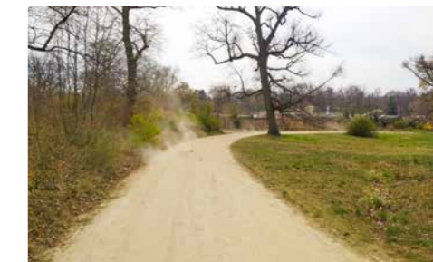
Abbildung 3: Winderosion auf einer wassergebundenen Wegedecke im Park Babelsberg © SPSG, Katharina Matheja
