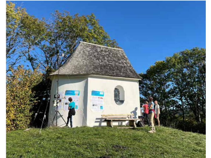
Abbildung 6: Die Frauenberg-Kapelle 2 Jahre nach der erneuten Sanierung am Europäischen Tag der Restaurierung 2022 mit dem Thema Klimawandel und Kulturerbe. Links im Bild eine Wetterstation des Fraunhofer IBP zur Messung von Klimaparametern und Schlagregen. © Fraunhofer IBP, 2022
