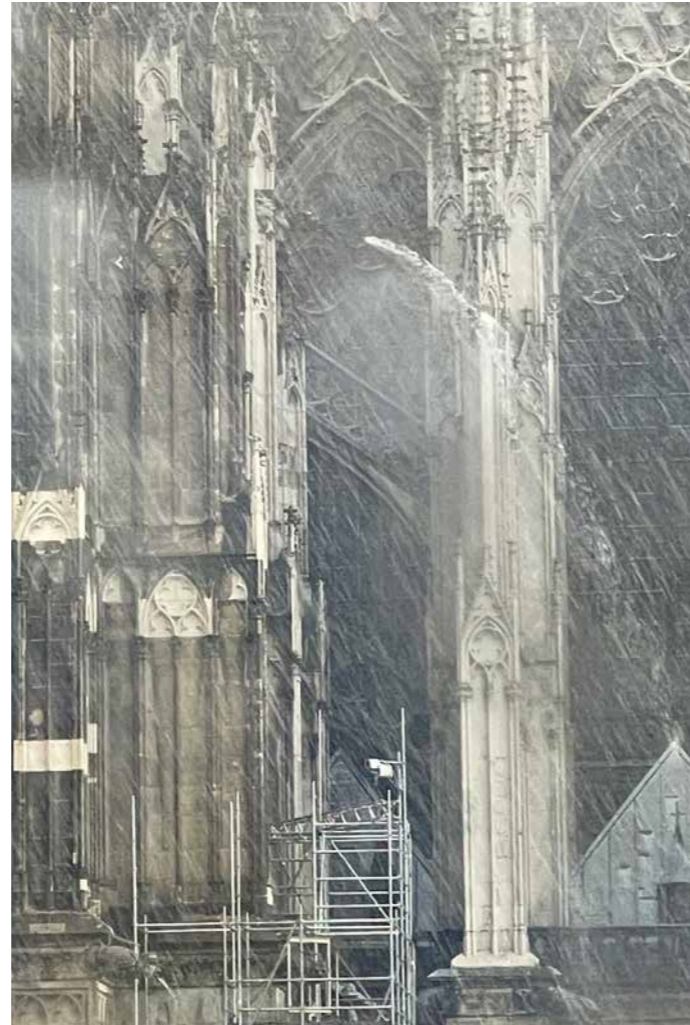
Abbildung 7: Ableitung und Ablauf des Regenwassers durch einen Wasserspeier des 19. Jahrhunderts als gewaltige Fontäne © Hohe Domkirche Köln, Dombauhütte
