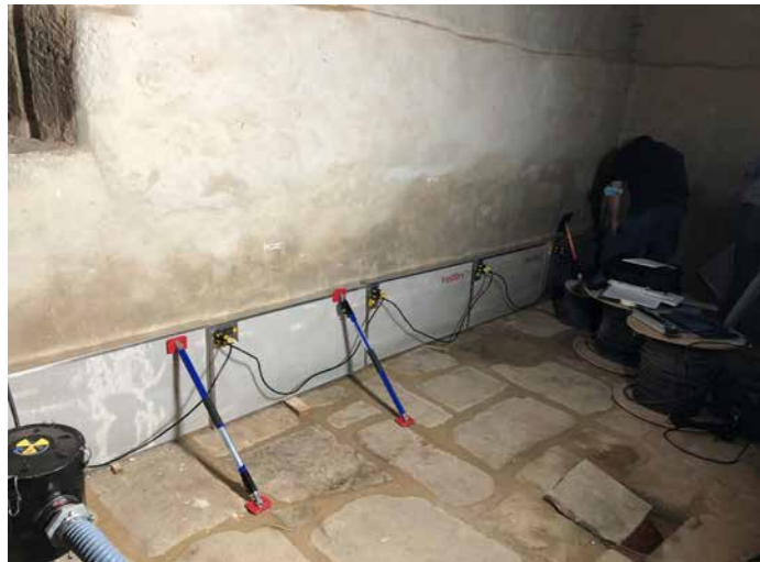
Abbildung 3: Nach der Flut im Juli 2021 wurde im Badhaus im Freilandmuseum Bad Windsheim erstmals FastDry, ein innovatives und energiesparendes Trocknungssystem des Fraunhofer IBP, in einem historischen Gebäude erfolgreich zum Einsatz gebracht (links). Die Thermographie (rechts) zeigt in Blau den Durchfeuchtungshorizont in den Wänden nach der Flut. © Fraunhofer IBP
