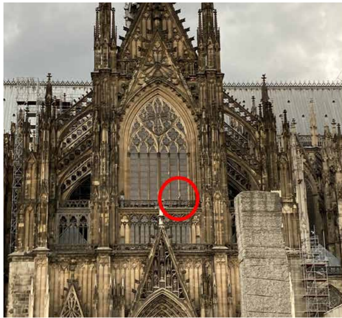
Abbildung 11: Positionierung des Messaufbaus an der Südfassade des Kölner Doms (links) und Detailsicht (rechts) der Wetterstation (vorn im Bild) sowie des 3D-Anemometers (hinten) in 1,5m Abstand zur Fassade © Fraunhofer IBP
