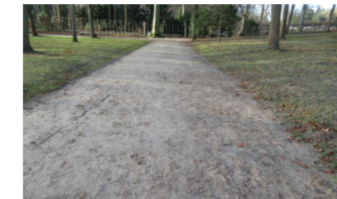
Abbildung 4: Aufgeweichte Wegedecke nach Starkregenereignis im Park Sanssouci © SPSG, Heiko Muschick
