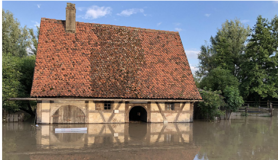
Abbildung 2: Vom Aisch-Hochwasser im Juli 2021 betroffene historische Gebäude © Freilandmuseum Bad Windsheim
