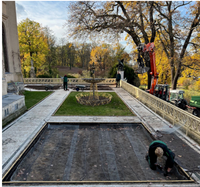
Abbildung 5: Verlegung einer unterirdischen Tropfbewässerung bei der Wiederherstellung der Terrassenanlage am Schloss Babelsberg © SPSPG, Katharina Matheja
